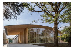
体育館・セントラルロッカー Physical Education Center/ Central Locker Building
